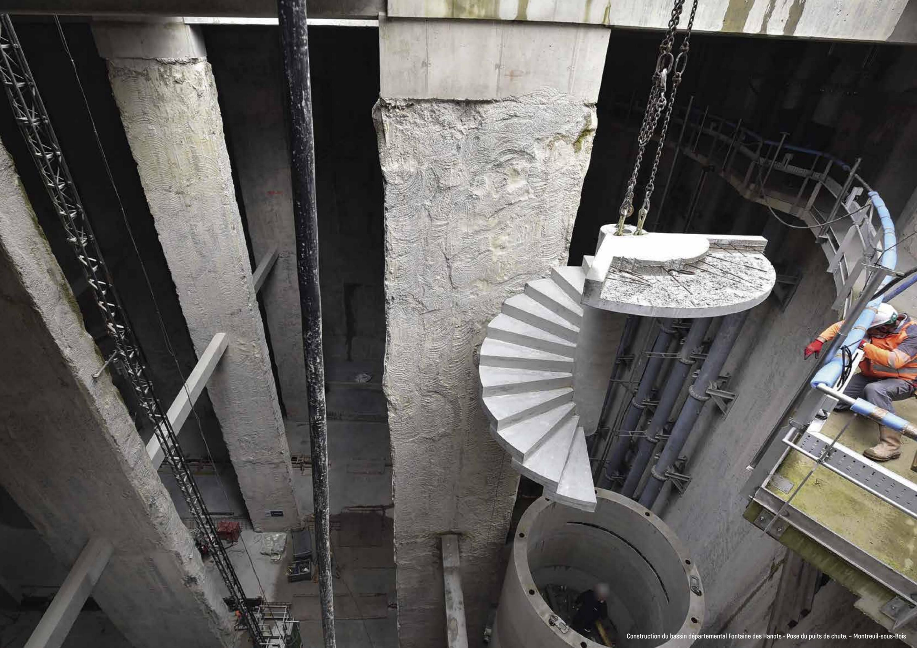
Construction du bassin départemental Fontaine des Hanots - Pose du puits de chute. - Montreuil-sous-Bois
