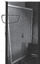
armoire haute abîmée
