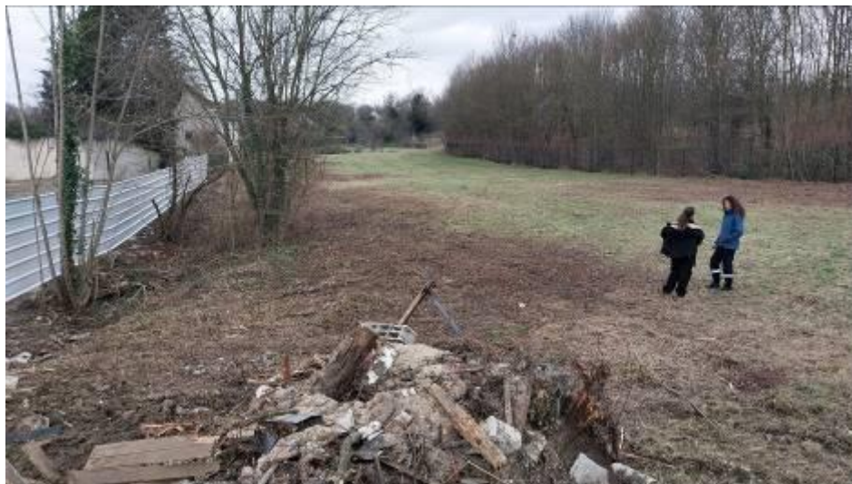
Déchets de chantier au niveau du portail côté avenue Henri Barbusse
