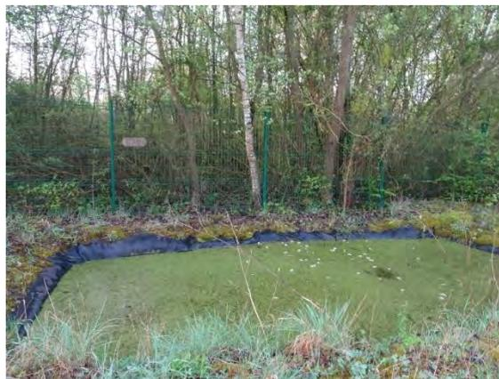
**FIGURE 18 : BASSIN DE RÉTENTION EN BORDURE DES VOIES (EGIS, 2022)**
