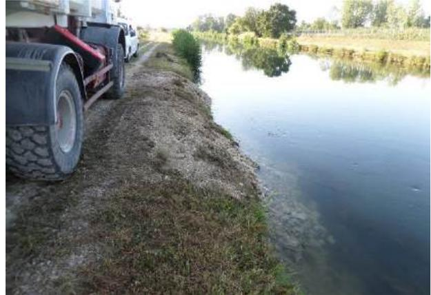
Confortement réalisé avec des enrochements afin de stabiliser la berge du canal de restitution Seine
