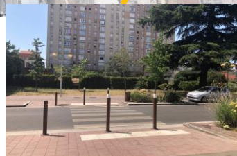
Faible confort : assises / sanitaires / point d'eau ?
