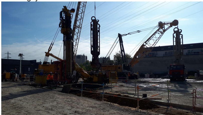
Saint Baudile – Gagny – Réalisation des parois moulées
