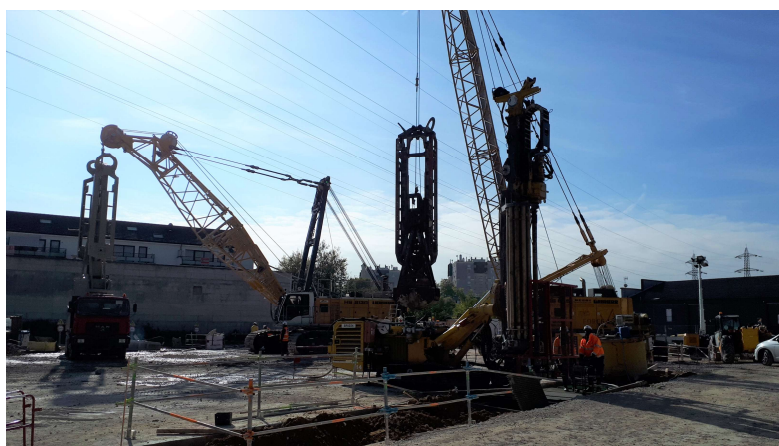
Chantier du Bassin du Ru Saint Baudile – Gagny
