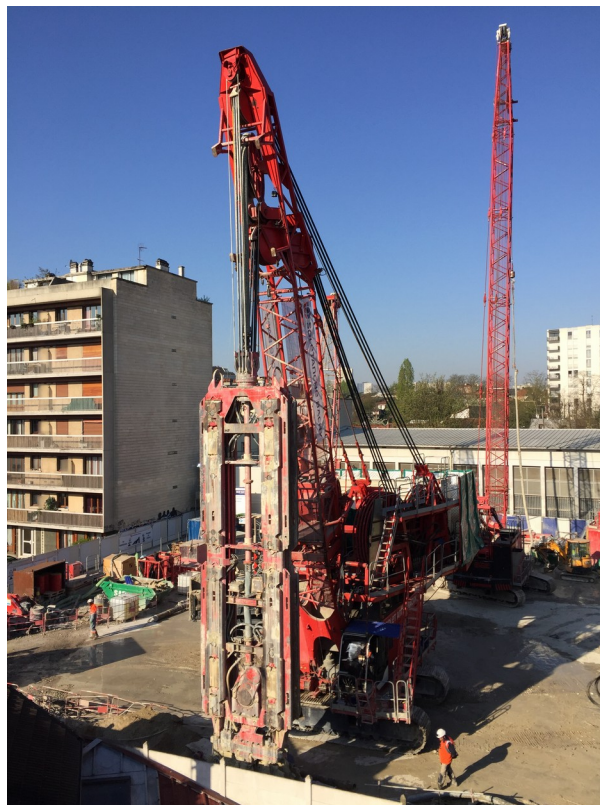
Chantier du Bassin Fontaine des Hanots – Montreuil-sous-Bois
