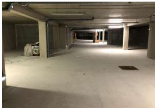
Parking principal en construction : 150 places
