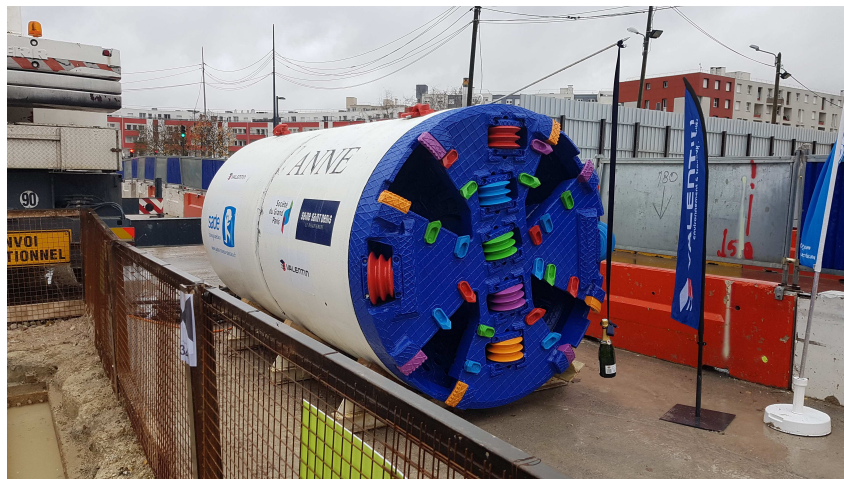
Tunnelier « Anne » - Création des siphons de Sevrans-Gare SGP Ligne L 16
