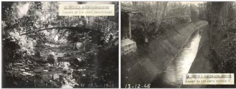
Le Croult à Garges-lès-Gonesse, avant et après reprofilage en 1946
