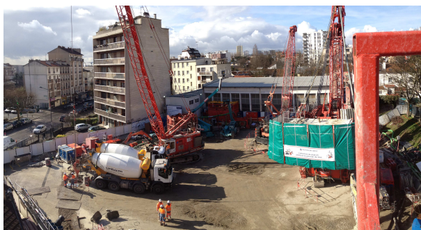
Bassin de la Fontaine des Hanots à Montreuil
